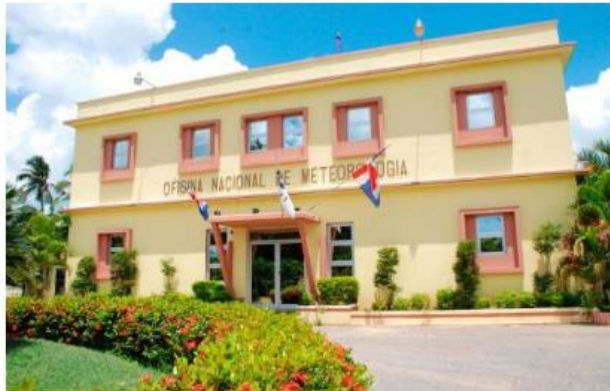
Vista de la fachada de la Oficina Nacional de Meteorología.
